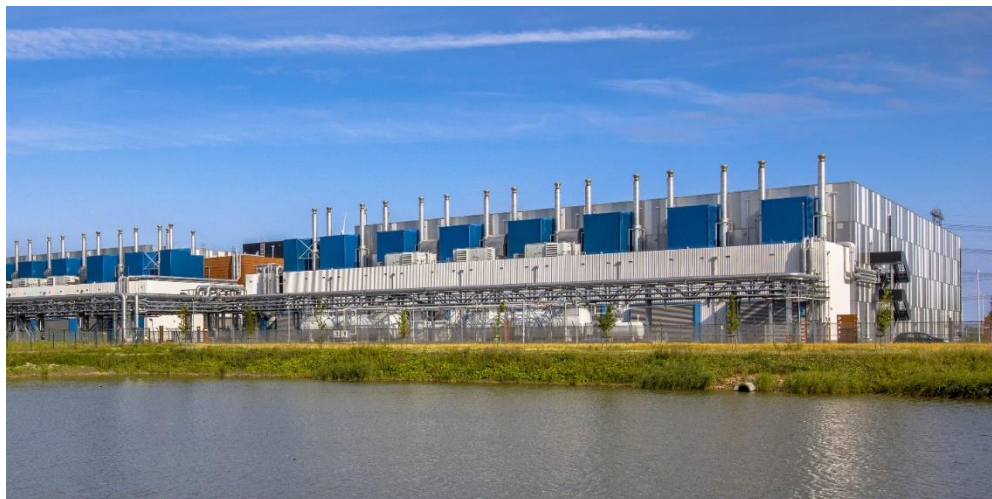
Figuur 6: Google datacentrum, Eemshaven. - Foto: Shutterstock.
